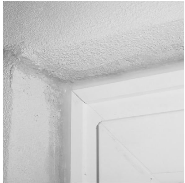
Bilder 1 und 2 Detailausschnitt obere Eckausbildung raumseitiger Anschluss vor und nach Abdichtung mit Dichtstoff zur Putzleibung.
