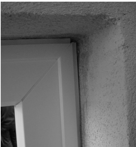
Bilder 3 und 4 Detailausschnitt obere Eckausbildung außenseitiger Anschluss vor und nach Abdichtung mit Dichtstoff zur Putzleibung.
