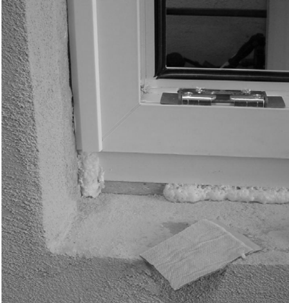
Bilder 5 und 6 Detailausschnitt unterer Eckbereich raumseitiger Anschluss vor und nach Abdichtung mit Dichtstoff und im Brüstungsbereich mit Fugendichtband.
