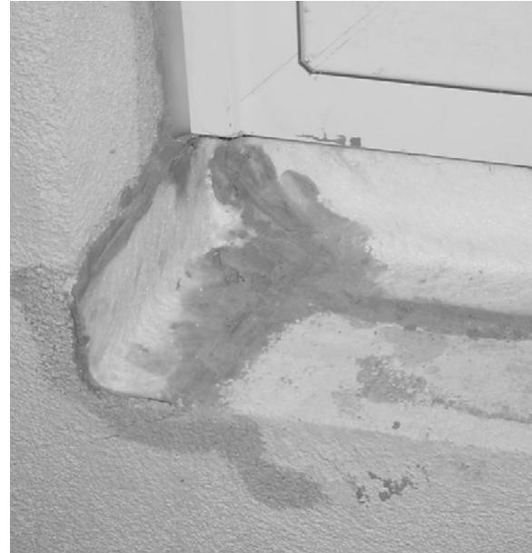
Bilder 5 und 6 Detailausschnitt unterer Eckbereich raumseitiger Anschluss vor und nach Abdichtung mit Dichtstoff und im Brüstungsbereich mit Fugendichtband.
