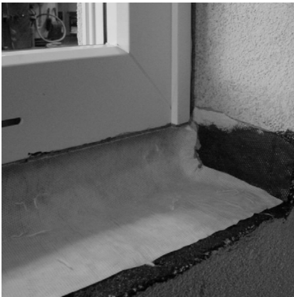
Bilder 7 und 8 Detailausschnitt unterer Eckbereich ohne und mit Aluminiumfensterbank.
