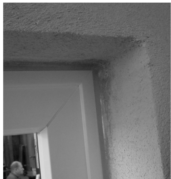
Bilder 3 und 4 Detailausschnitt obere Eckausbildung außenseitiger Anschluss vor und nach Abdichtung mit Dichtstoff zur Putzleibung.
