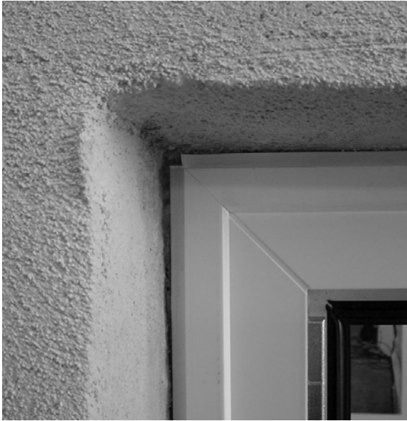
Bilder 1 und 2 Detailausschnitt obere Eckausbildung raumseitiger Anschluss vor und nach Abdichtung mit Dichtstoff zur Putzleibung.
